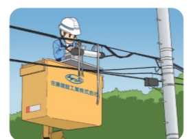
光ファイバー敷設
