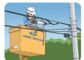
光ファイバー敷設
