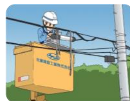
光ファイバー敷設
