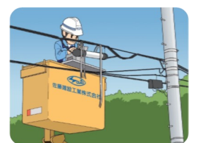
光ファイバー敷設
