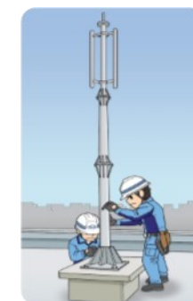
携帯電話無線基地局の建設
