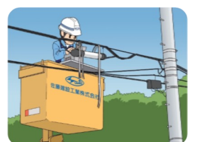
光ファイバー敷設
