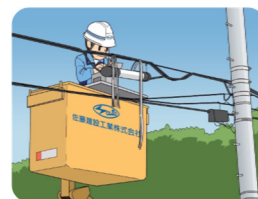
光ファイバー敷設
