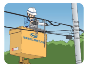
光ファイバー敷設
