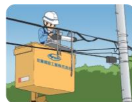
光ファイバー敷設
